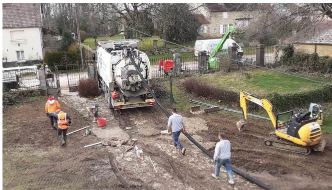
Het aansluiten van het riool was een flinke klus.
