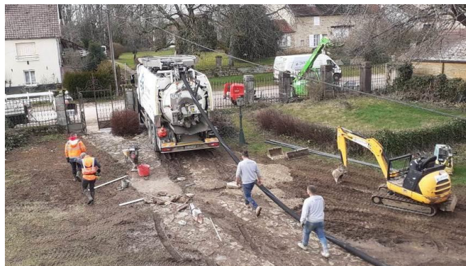
Le raccordement à l'égout a été un gros travail.
